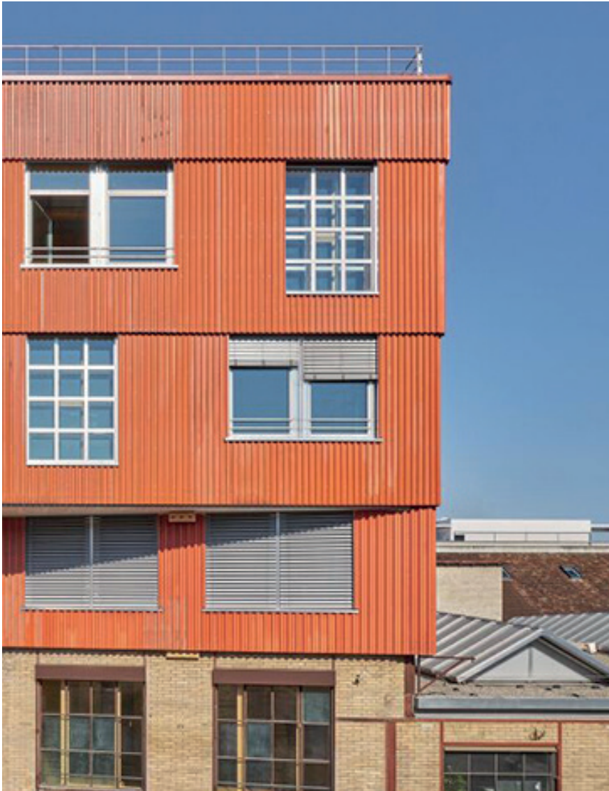
Referenzbeispiele Fassadenelemente aus Wiederverwendung. K. 118 – Kopfbau Halle 118 insitu 2021
