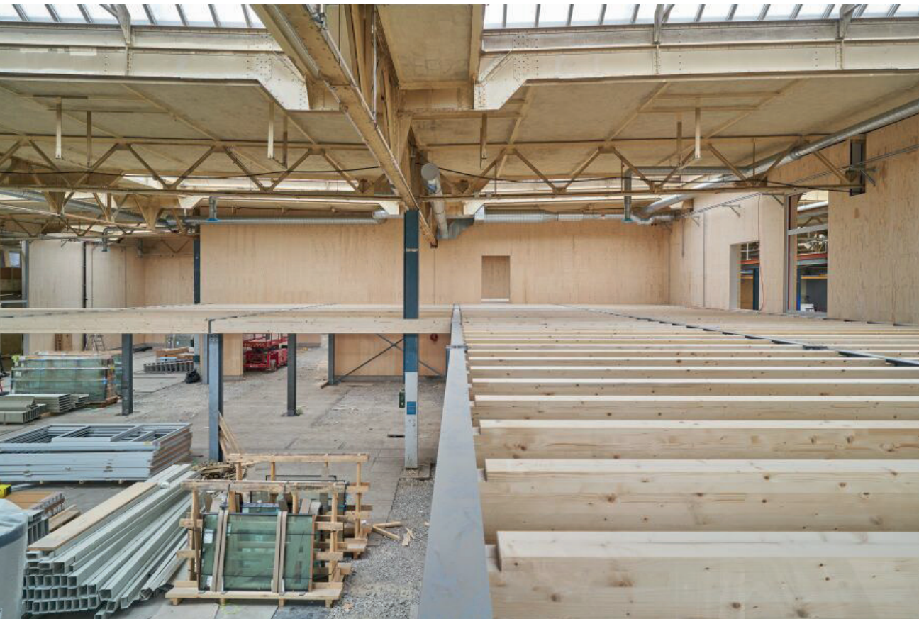
Referenz Halle Q - SBB Werkstätte Zürich Tragstruktur Einbauten aus alten Fahrleitungsmasten und Holz insitu 2024
