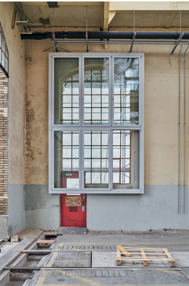
Referenz Halle Q - SBB Werkstätte Zürich Kastenfenster als Aufdopplung der bestehenden Fenster insitu 2024
